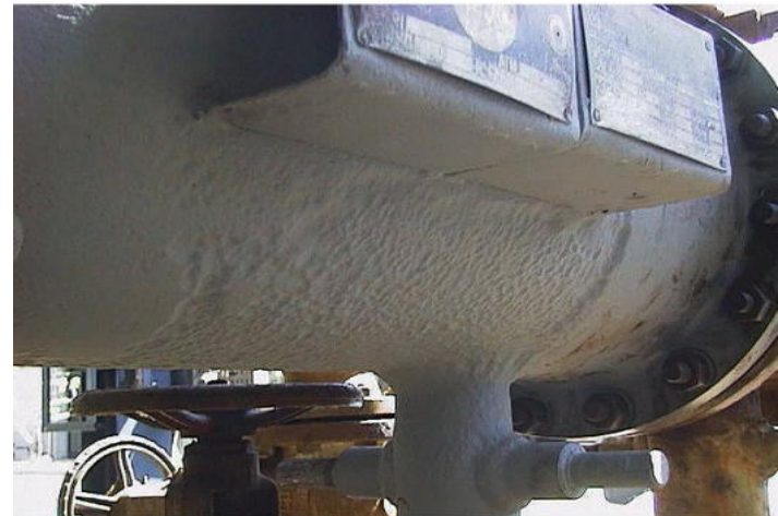
027 E-47 Particolare della corrosione esterna sulla superficie del mante
