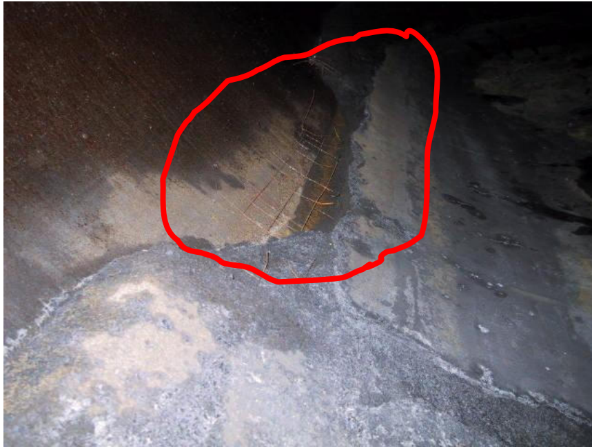
Danneggiamento rivestimento in cemento ancorato con sistemi diversi
