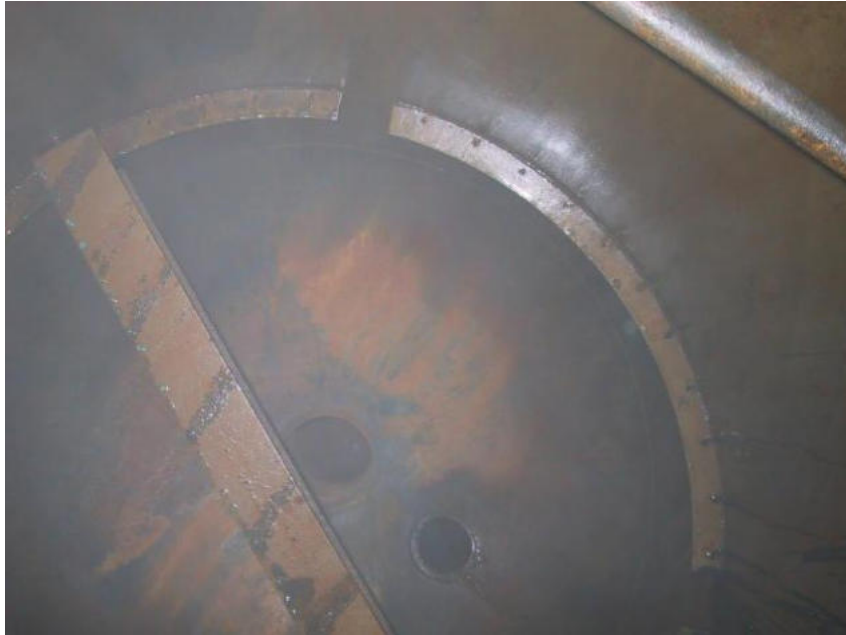
Interno Apparecchiatura Visto dal basso un supporto deminster
